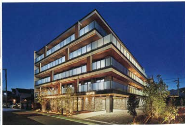
北東側外観夕景
